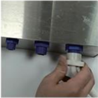
Свързване с водопровода
